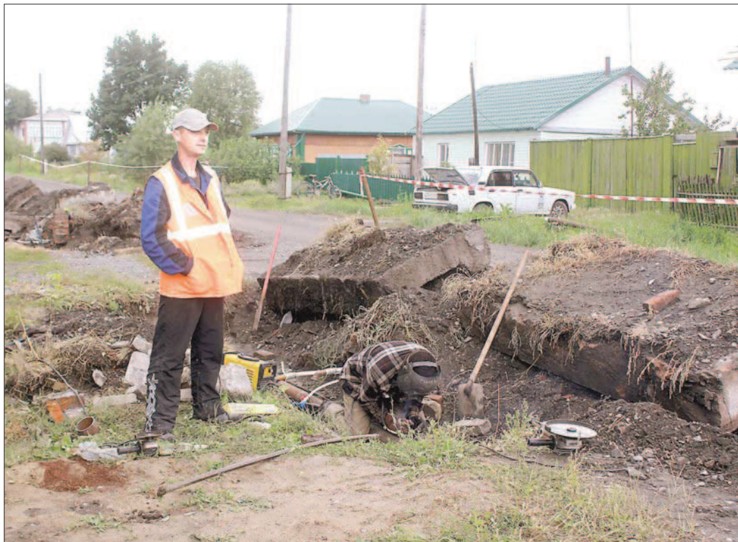
Ремонтные работы по ул. Чапаева
