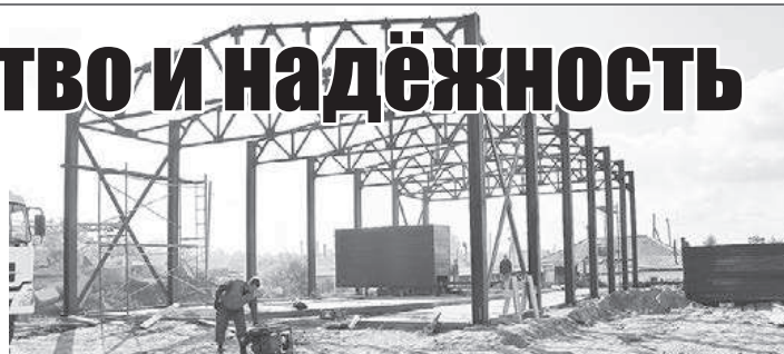
Возводится модульная котельная в р. п. Краснозёрское (мощность 7,5 Гкал/час)
