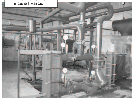
Новая котельная в селе Гжатск.
