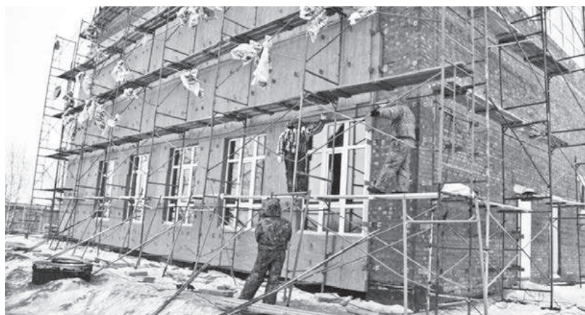
Строители утепляют здание.
